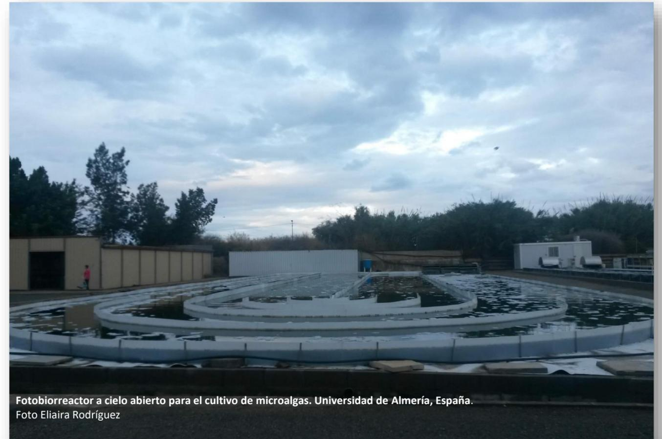
Fotobiorreactor a cielo abierto para el cultivo de microalgas. Universidad de Almería, España.
